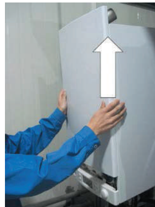
3. Передвиньте переднюю панель вверх и вперед.
