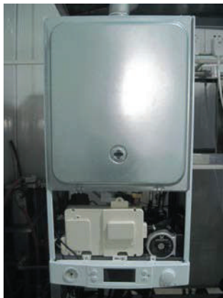
5. Снимите переднюю панель..
