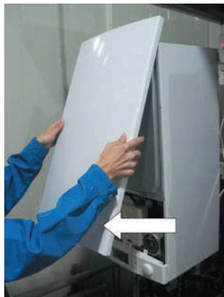
4. Поднимите вверх и снимите переднюю панель.
